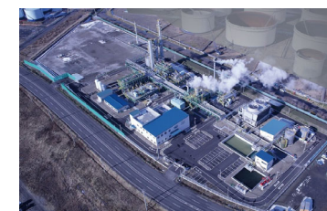
CO2分離・回収・貯留施設
