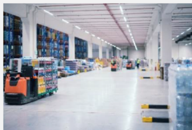
最新設備を導入した 物流センター
