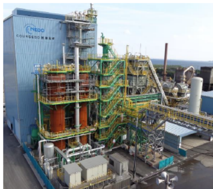
12m 3 小規模試験高炉(水素還元)
