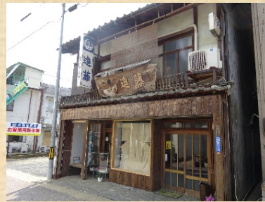
復旧後の写真
