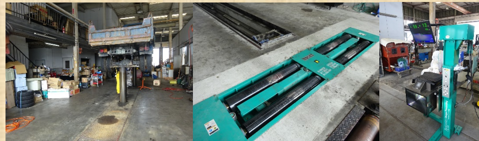
復旧後の工場内と修繕した設備
