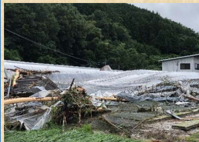
倒壊したビニールハウス
