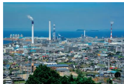
三島公園から望む三島川之江港付近の工業地帯 (出典: 四国中央市)
