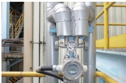
▲蒸気量の計測
