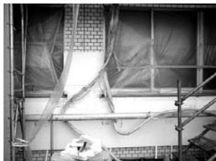
▲外断熱工事により空調設備の負担が減った。
