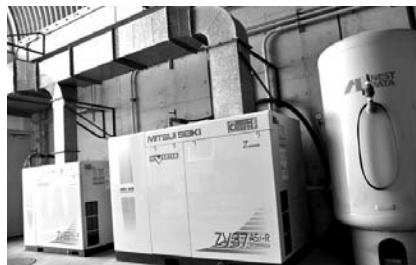
▲手前が37kWのコンプレッサー。
