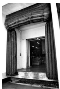
▲クッション性のある素材と、すだれのようなシートで気密性を高めるアーマー式。
