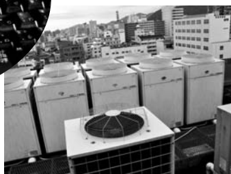
▶監視装置のアラームが鳴ると室外機が自動で止まる。
