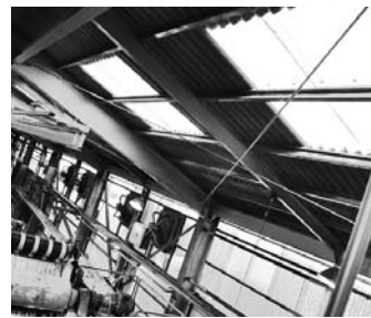
▲明かり窓で昼間は随分と明るく、照明いらず。
