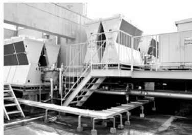
▲効率の良いヒートポンプチャラー。
