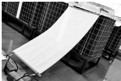
▲空調室外機の日よけ。これだけで随分と効果が上がる！
