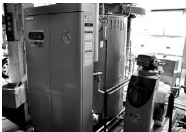
▲都市ガス型ボイラー。環境にも優しい。
