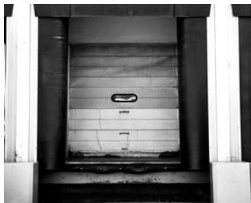
▲クッション性のある素材と、すだれのようなシートで気密性を高めるアーマー式。
