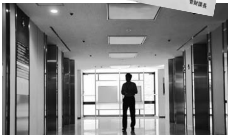
▲こちらがエレベーター前。消灯を徹底しているので結構暗いが、案内板には LED スポット照明による工夫が!
