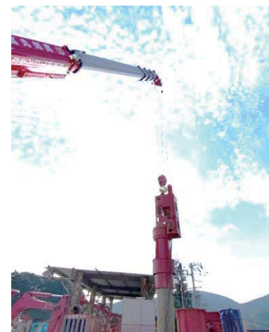
建設機械掘削機オーガー
